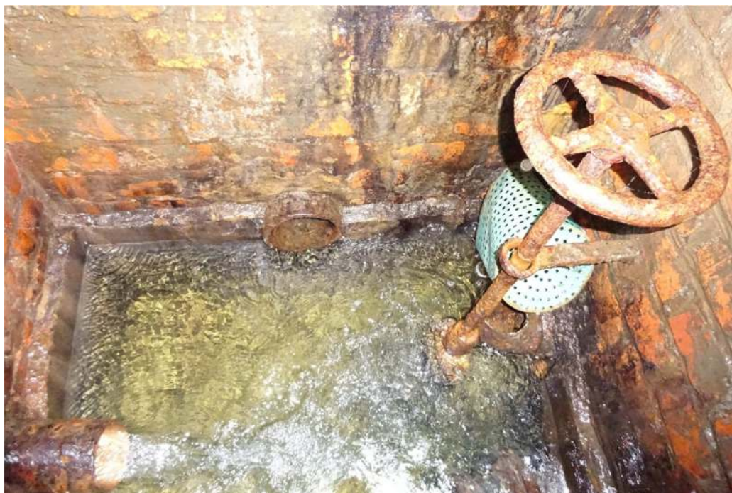
Obr. 2 Stavebně-technický stav jímacích objektů
